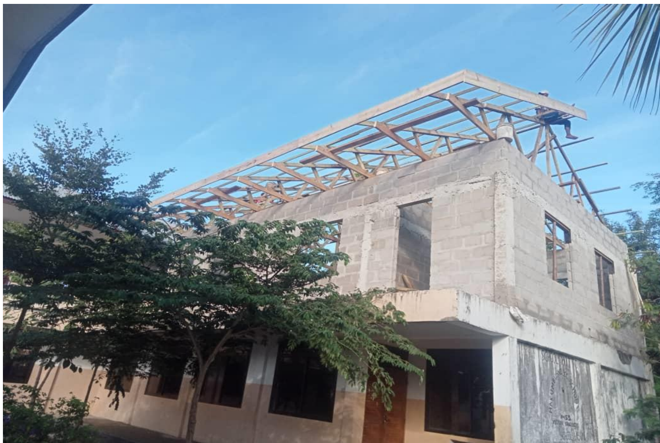
Picha Na. 2: Hatua ya upauaji chumba 1
