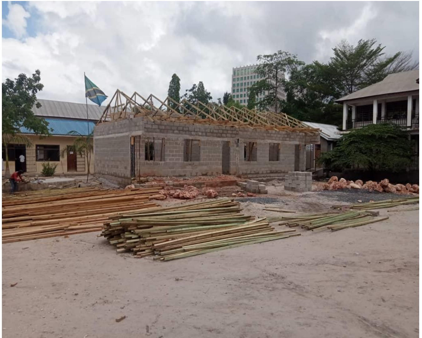
Picha Na. 1: Hatua ya upauaji wa vyumba 2
