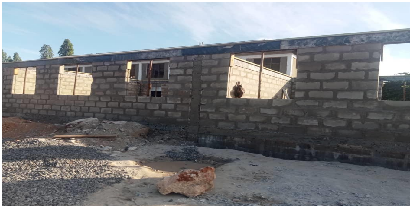
Picha Na. 2: Ujengaji tofali baada ya lenta vyumba 5
