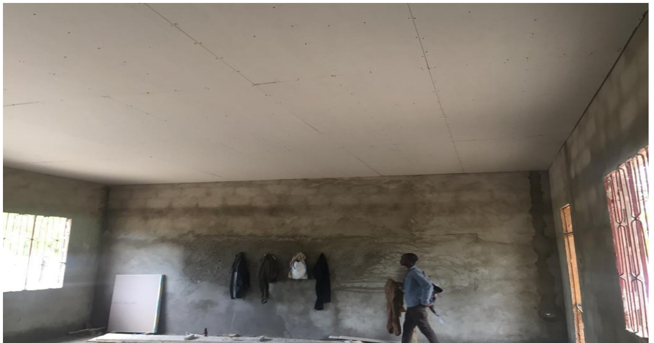
Picha Na. 2: Sehemu ya ndani ya darasa ikiwa imeshawekwa gypsum board
