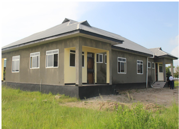
Muonekano wa Nyumba ya Mwalimu wa Shule ya Sekondari Mbweni Tetaliyopo Kata ya Mbweni Manispaa ya Kinondoni.
