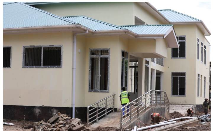
Muonekano wa jengo la Kituo kipya cha Afya cha Kinondoni
